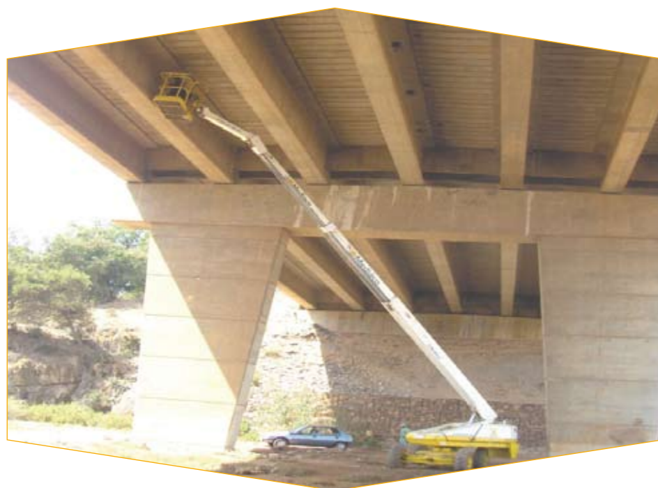
Ouvrage récent en béton précontraint.
