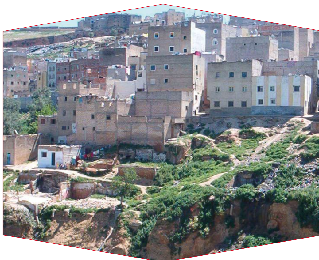
Quelques bâtiments menaçant ruine à Hah Hassani à Fès.
