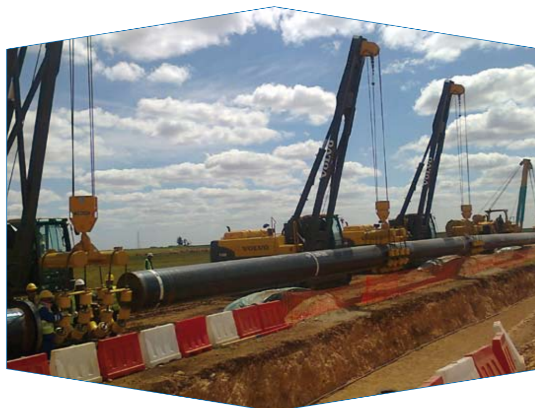
Le LR d'El Jadida assure le contrôle externe auprès de l'entreprise turque Tekfen chargée des travaux.
