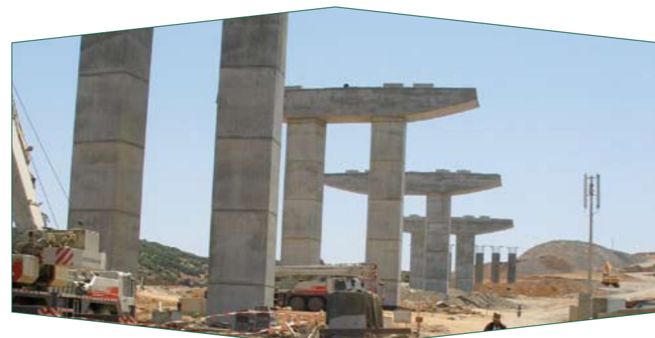
Poutres longitudinales en béton du viaduc d'accès au pont à haubans.
