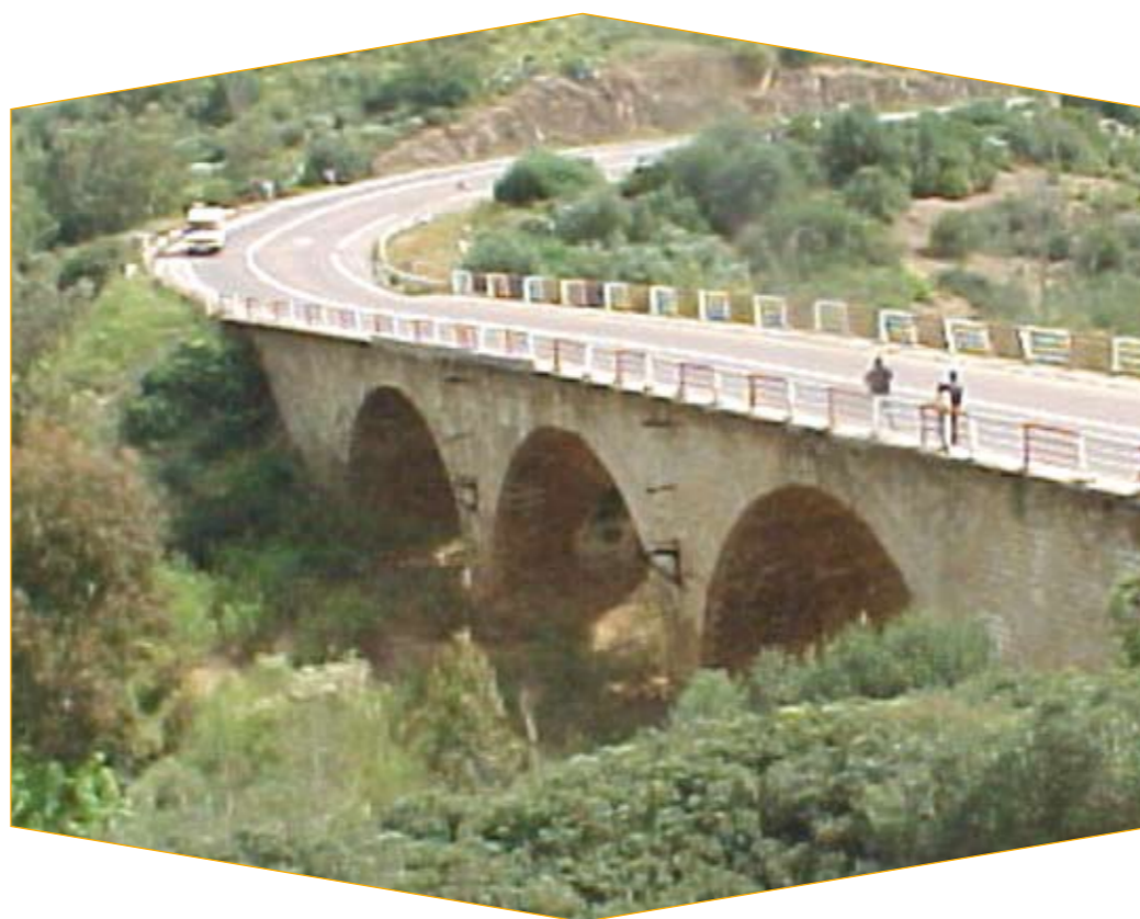
Ouvrage ancien en maçonnerie.
